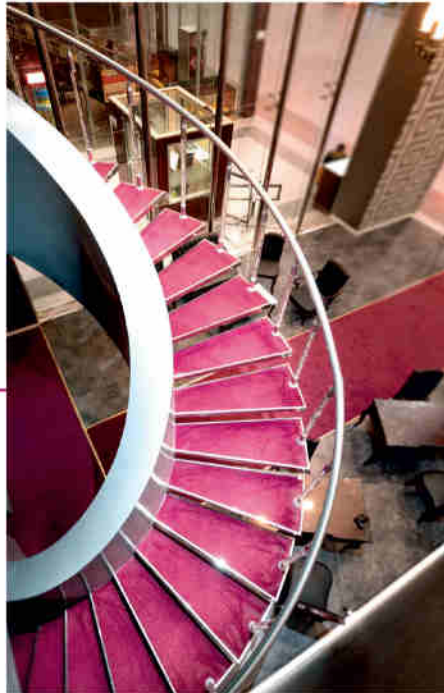
هيكل كابولي احادي الجانب ارضية الدرج معدني درايزين من اكرليك شفاف
