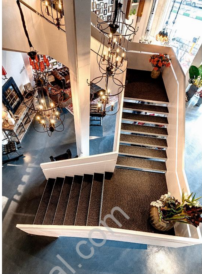
پروژه خانه درسا . تهران سازه شمشیری دو طرفه باکس بلند کف پله فلزی . نرده ورقه یکنارچه DOUBLE STRINGERS
