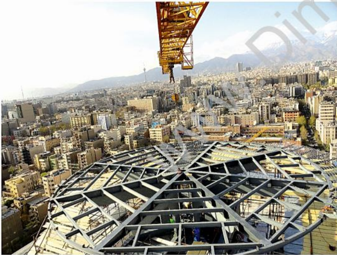
طراحی، محاسبات سازه ای، ساخت و نصب هلی پد (باند هلیکوپتر امداد و تشریفات)
