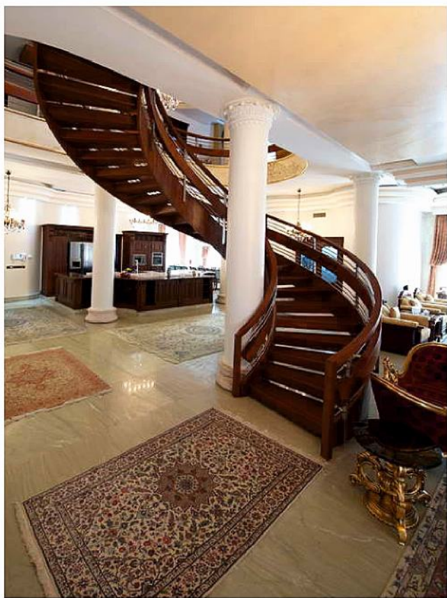
سازه شمشیری دو طرفه باکس کف پله چوب . نرده تلفیق استیل با چوب DOUBLE STRINGERS WOOD STEPS STEEL HANDRAIL COMBINE WITH WOOD
