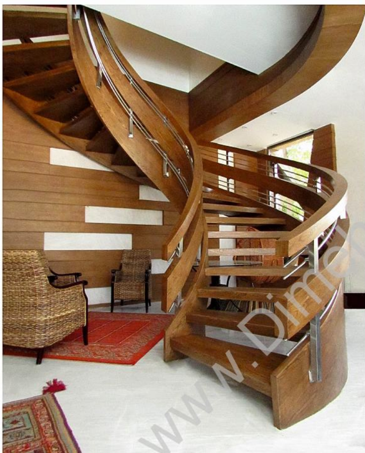
سازه شمشیری دو طرفه باکس کف پله چوب . نرده تلفیق استیل با چوب DOUBLE STRINGERS WOOD STEPS STEEL HANDRAIL COMBINE WITH WOOD
